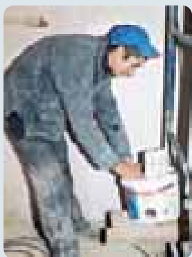
Воспитанник детского дома Евгений Дидук работает штукатуром на строительстве нового развлекательного комплекса в Харькове.
