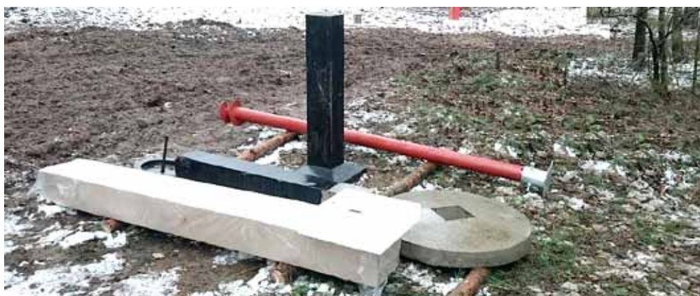
Рис. 35. Винтовая свая
