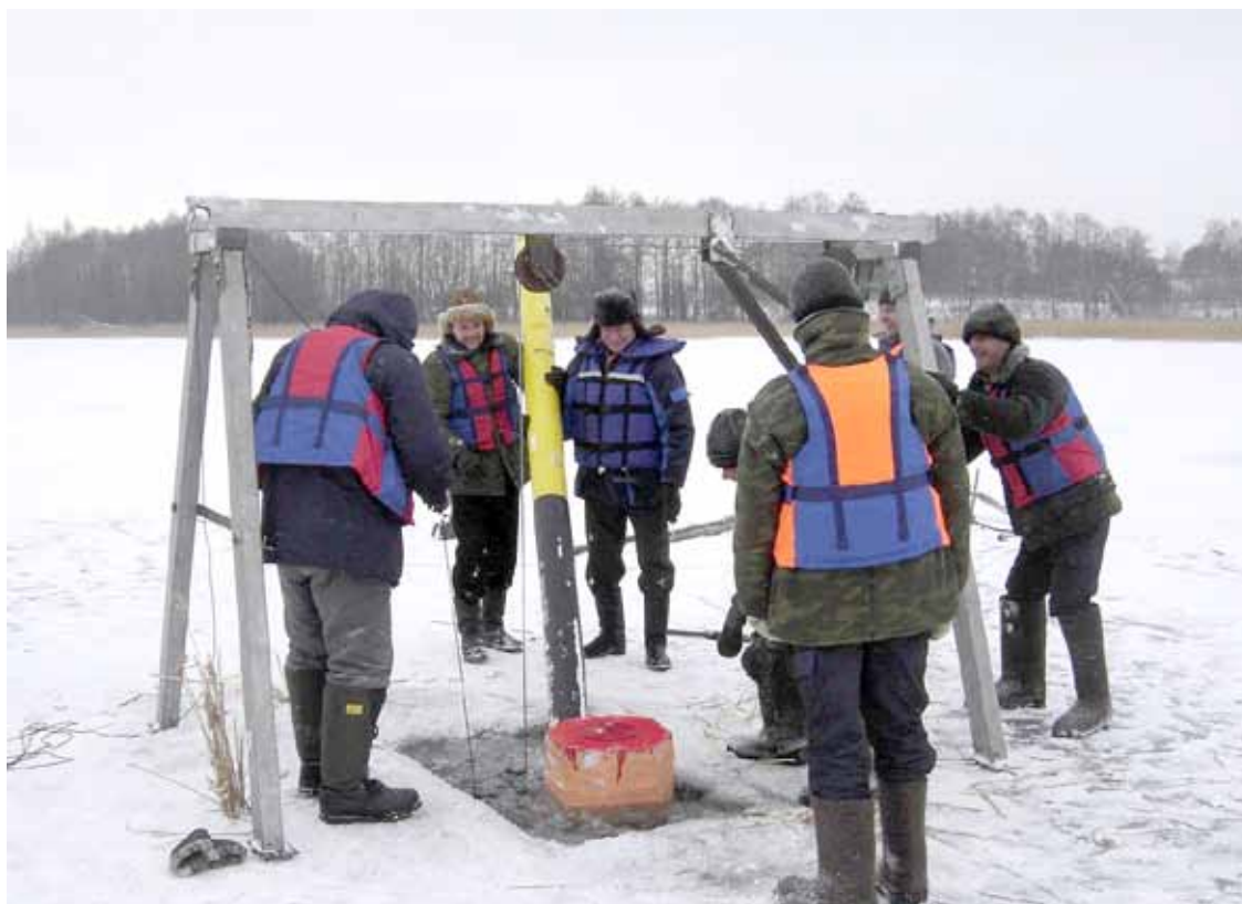
Рис. 36. Установка озерного пограничного знака (буя) с поплавком.
