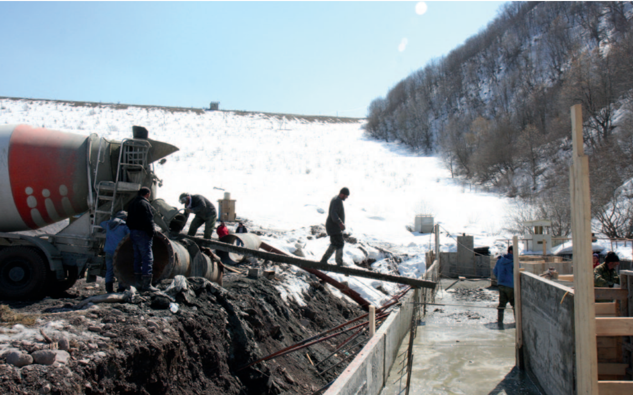
Ремонт правого крыла рабочего водосброса дамбы в Зонкари, март 2012 года (ОБСЕ/Эммануэль Анкетил)
