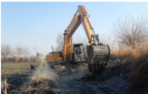
Комплексное учение в районе Восе, выполнение берегоукрепительных работ (укрепление габионными сетками) на канале «Хукумат» и очистка канала в селе Гулистон
