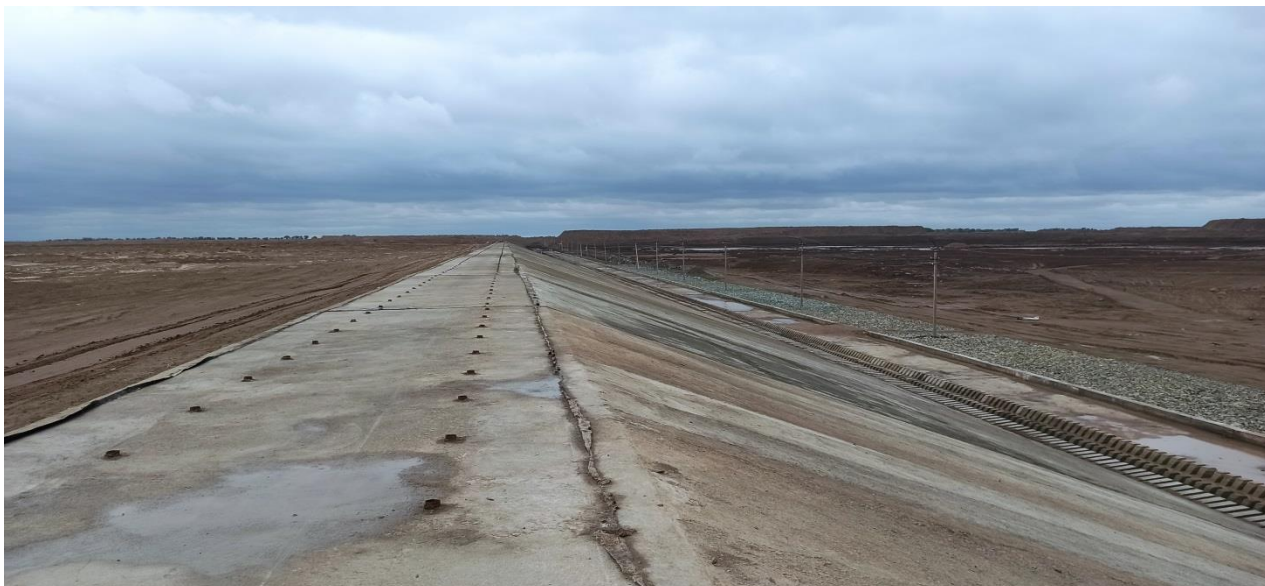
Рис. 6. Общий вид строящегося водосливного сооружения (фото В. Соколова 9 мая 2022 года)
