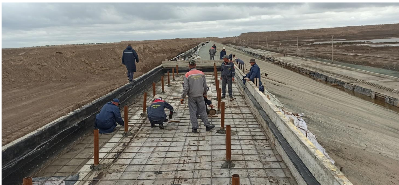
Рис.7. Работы по бетонированию незавершенной части водосливного сооружения (фото В. Соколова 9 мая 2022 года)
