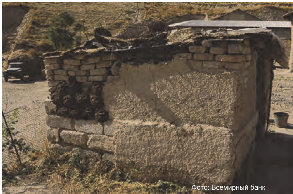
РИСУНОК 6. НЕУСОВЕРШЕНСТВОВАННАЯ УБОРНАЯ С ВЫГРЕБНОЙ ЯМОЙ (Источник: Всемирный банк)
