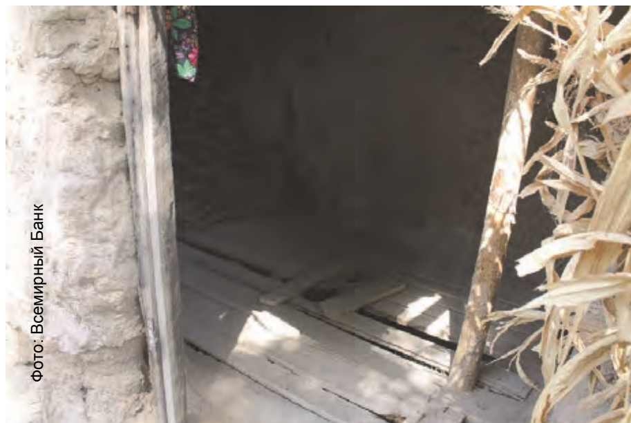
Рисунок 5. Неусовершенствованный туалет с выгребной ямой (Источник: Всемирный банк)
