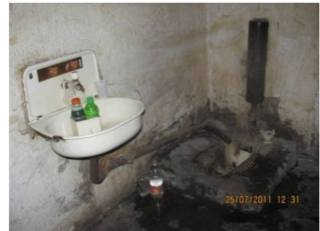
Санузел в камере.
