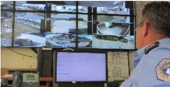
Kontrolna soba u RDP Uroševac
