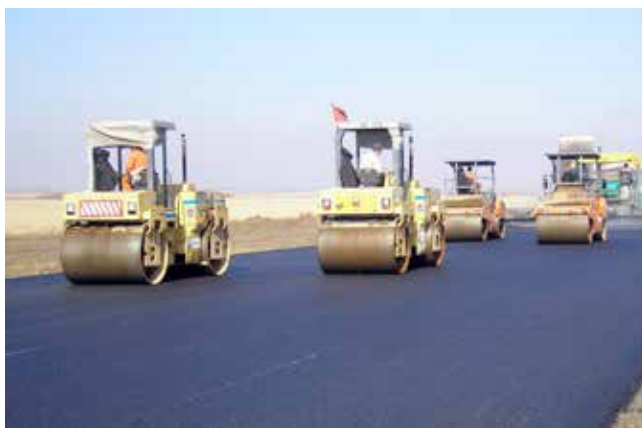
Строительство казахстанского участка автомагистрали «Западная Европа – Западный Китай»
