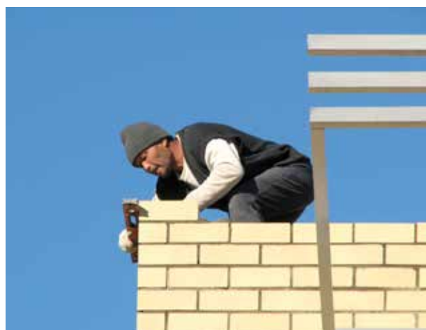
Рабочий укладывает кирпичи
