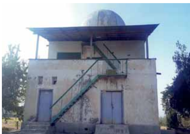
Действующее состояние здания противоградовой Службы
